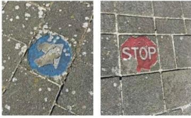
Versaagde verkeerstekens bij 't Pierement. En vervaagd verkeersbord bij 't Pierement.
